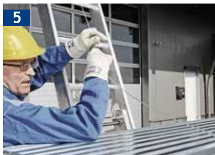
Fixieren der Arbeitsplattform am Schlitten
