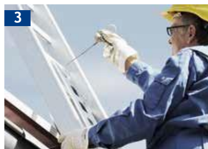
Einhängen der Umlenkung an der Leiter
