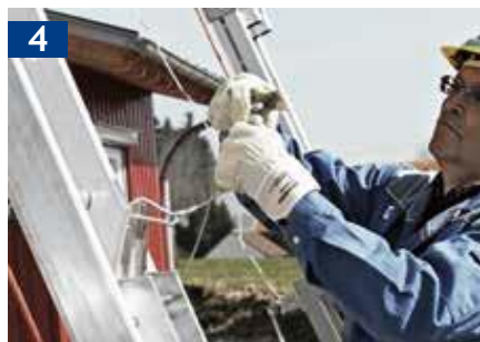
Befestigen des Schlitten am Seil der Winde
