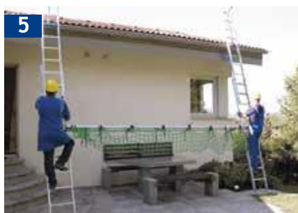
Geländer mit Netz aufbringen
