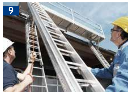
Positionieren der Zugangsleiter
