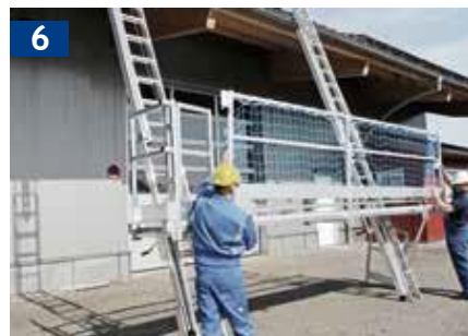
Anbringen der Geländer, Seitengeländer und Türmodul
