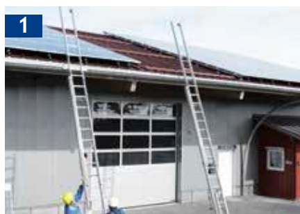
Aufstellen der BAVARIA-Leitern
