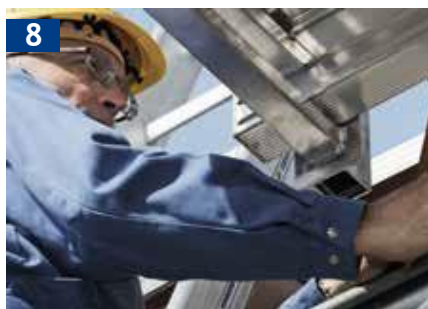
Sichern des Systems gegen Umfallen
