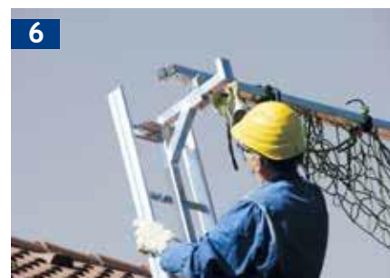
Oberen Schieber schließen
