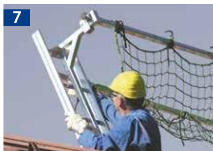
Unteren Schieber schließen
